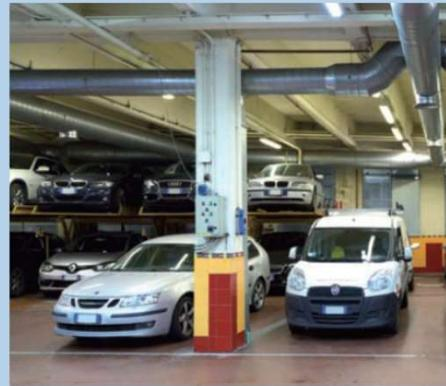
Consentiti **montauto** nell'autorimessa dotati di **alimentazione elettrica di riserva** (*istruzioni per la manovra in luogo visibile e misure di controllo dell'incendio almeno di livello IV di prestazione per le aree TA*).
